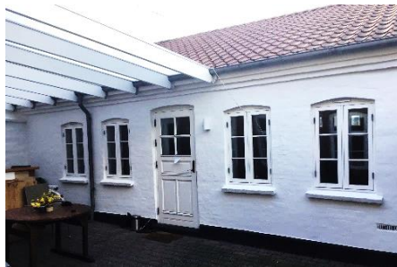
Tidligere værkstedsbygning i 2024
